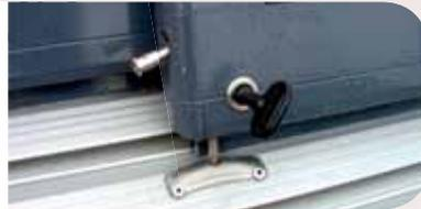
Die bewegbare Arretierungen der Schwimmbadüberdachungen sind versteckt und automatisch, sind leicht zu bedienen und auf Wunsch mit Schlüssel verschließbar.
